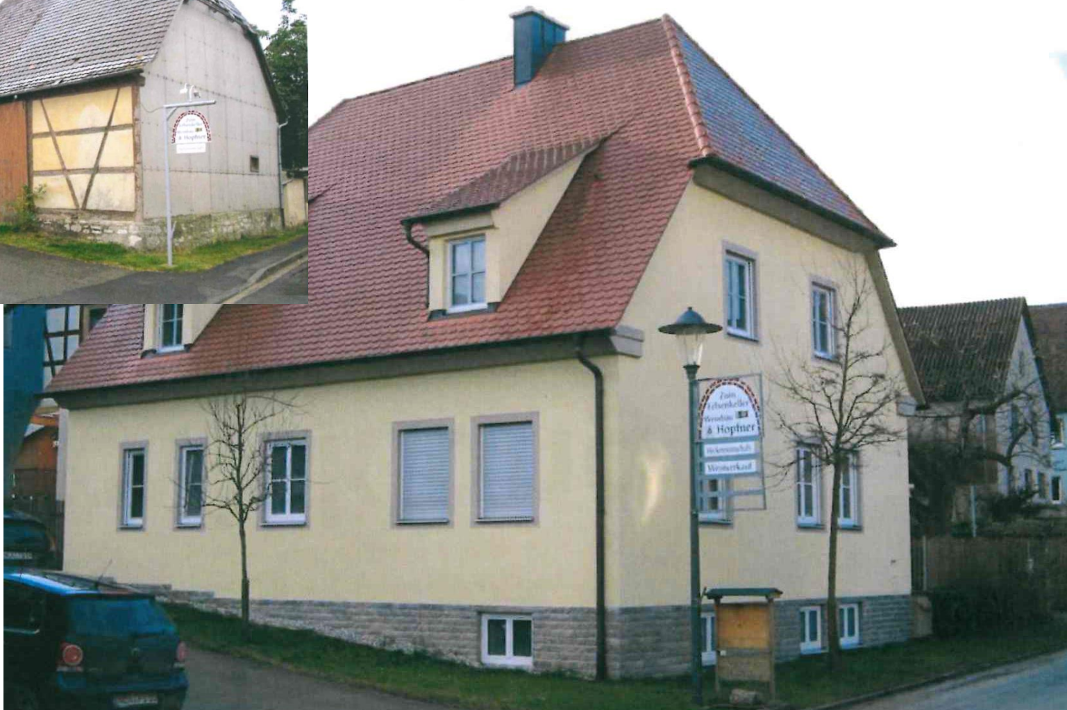
Umbau Scheune zu Wohnhaus
